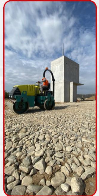
Se ejecutó la construcción de un patio de maniobras con plataforma de concreto armado, incluyendo trabajos de nivelación, compactación y vaciado de losa con pendiente para drenaje.
